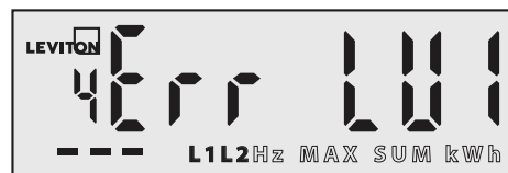
Pantalla de error que muestra un error de instalación de voltaje bajo en las Líneas 1 y 2
